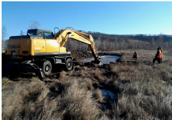
Рисунок 4 – Строительство нагорного канала
