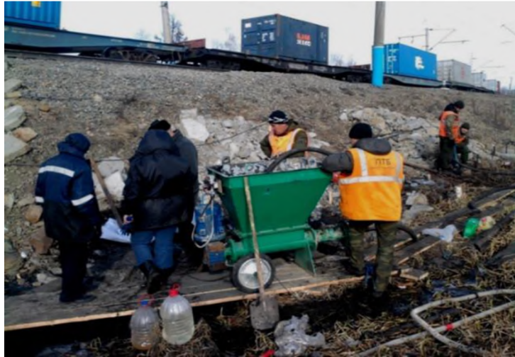
Рисунок 3 – Строительство противофильтрационного экрана
