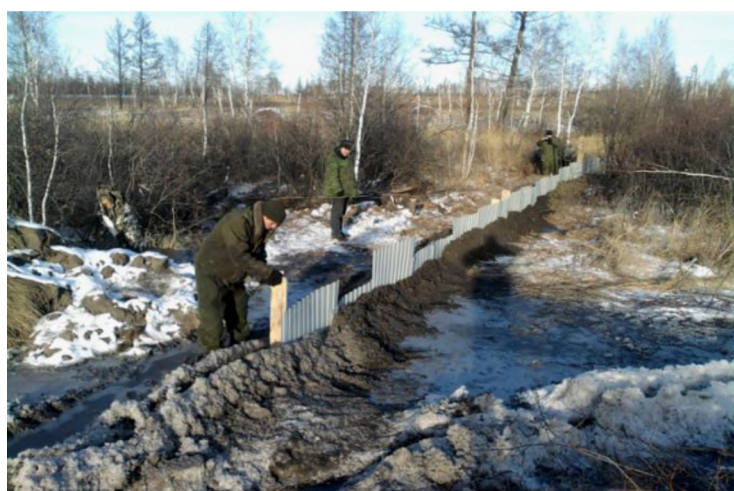
Рисунок 5 – Строительство экрана в русле ручья
