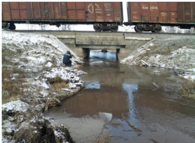
Рисунок 1 – Общий вид железнодорожного моста на ПК 3+75
